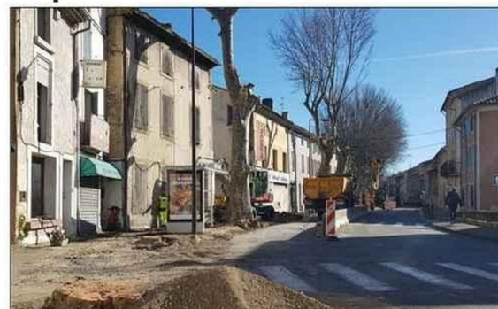
L'entreprise Braja-Vésigné intervient dans le cadre des travaux du boulevard Daladier.
