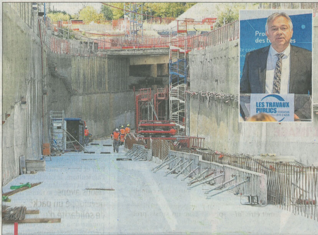
Les travaux publics - ici la construction d'une voie souterraine à Marseille -, sont une activité clé dans notre région. En médaillon, René Braja, élu en février président de la FRTP Paca. /PHOTOS VALÉRIE VREL ET DR
